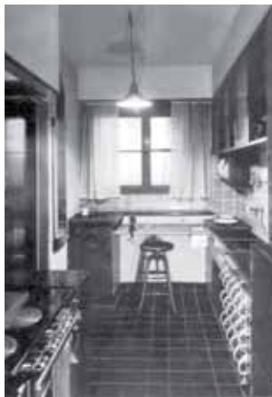
Die Mutter aller Einbauküchen: Mit dem Entwurf der „Frankfurter Küche“ 1926 durch die Wiener Architektin Margarete Schütte-Lohotzky war der Weg zur rationalisierten Einbauküche geebnet.
